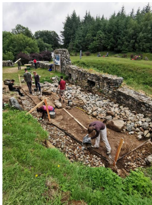
Remplissage du drain à l'aide de petits cailloux
