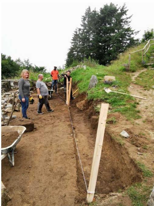
La tranchée creusée le long du cordeau
