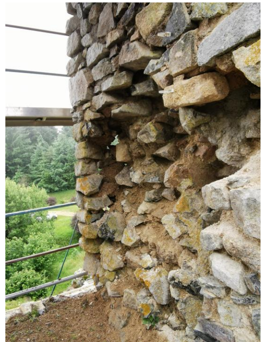
Le jambage de l'ouverture tient en équilibre
