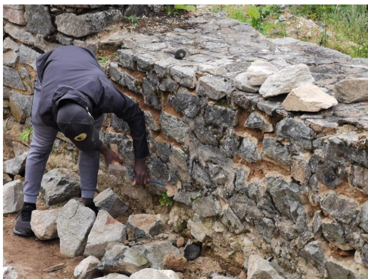
Piquage des anciens joints du mur d'enceinte
