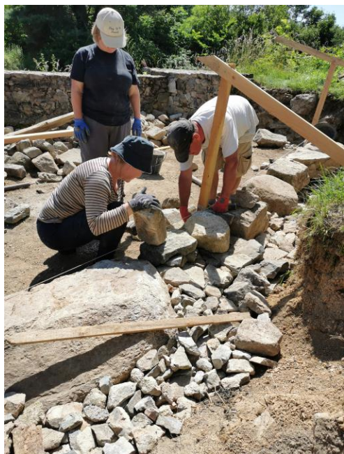
Construction du mur en pierres sèches
