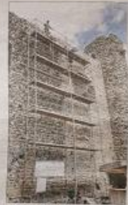
Restauration de la courtoine avant du château. Photo Progrès/Delphine LORON
