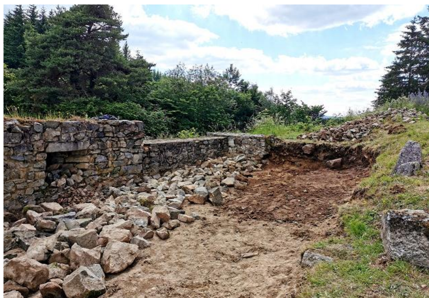
L'espace prévu pour le jardin avec les pierres transportées par les jeunes du SNU
